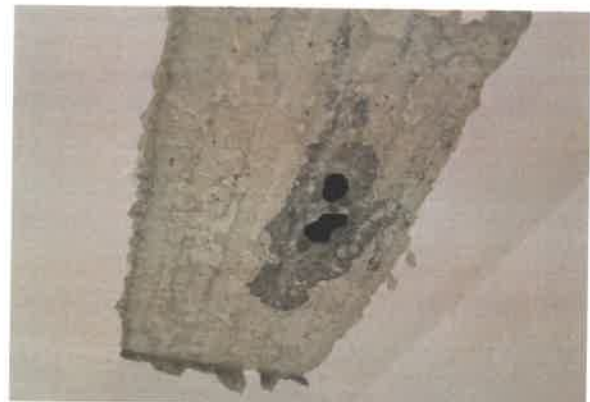
Sondaj PL01 placa beton armat prefabricat ax C-D,3-4, peste etaj 2: latime fasie=120cm , grosime fasie=12cm ,
