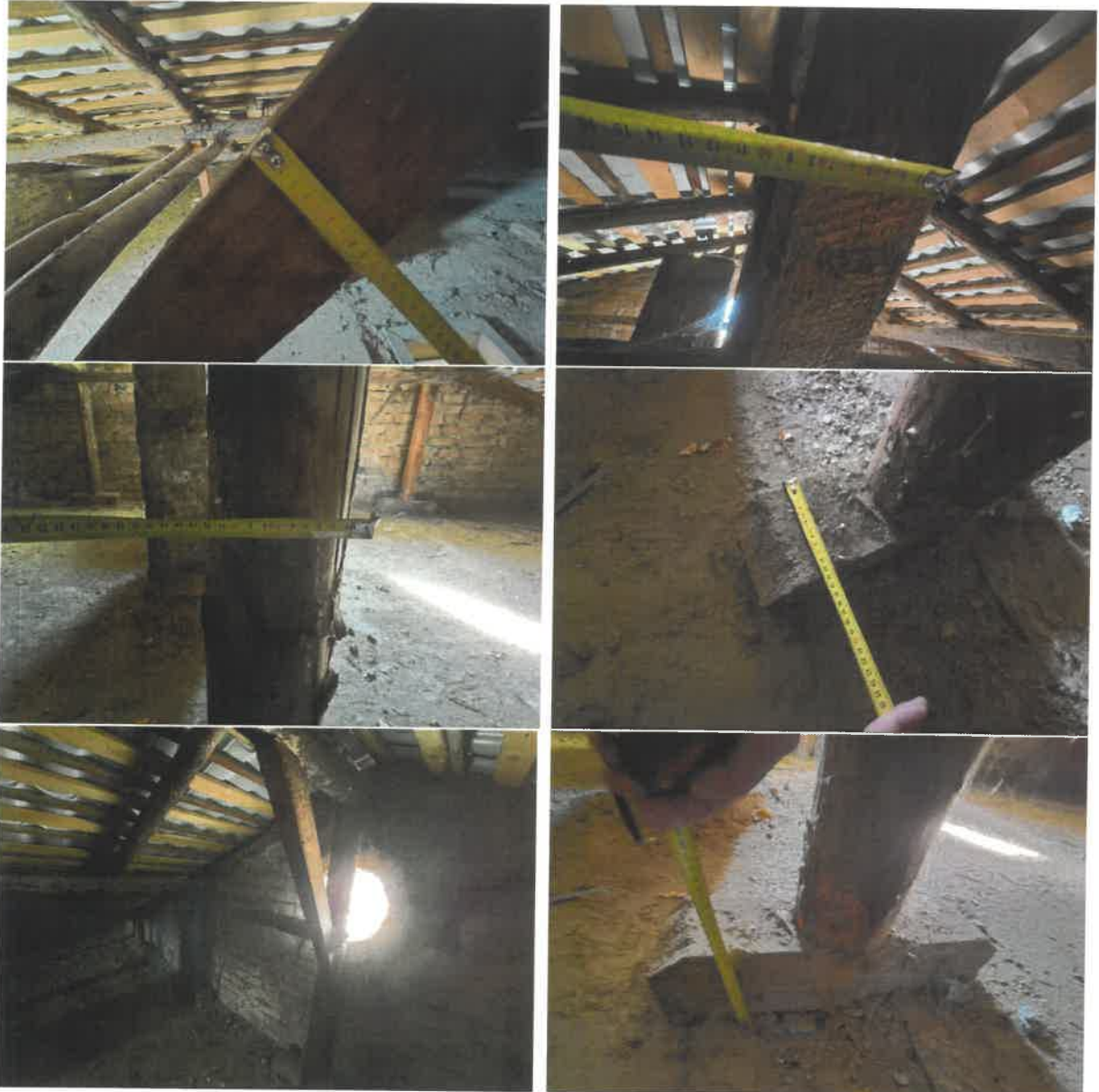
Masuratori sarpanta: caprii 8cm, pane \varnothing 10cm, popi \varnothing 12cm, talpi 12x12cm, elementele nu sunt ancorate de structura de rezistentă;
