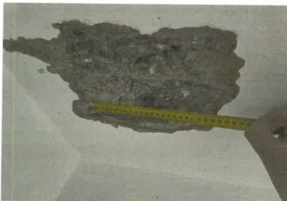
Sondaj PL01 placa beton armat monolit ax C-D,3-4, peste parter: grosime 15 cm, armare inferioara Ø10/15cm PC 52 pe directia lunga, armare superioara Ø10/15cm PC 52 pe directia scurta si Ø10/15cm PC 52 pe directia scurta si Ø10/15cm PC 52 pe directia lunga;
