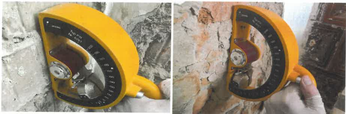
Incercari in situ cu sclerometrul unghiular Proceq pentru determinarea rezistentei la compresiune a mortarului
