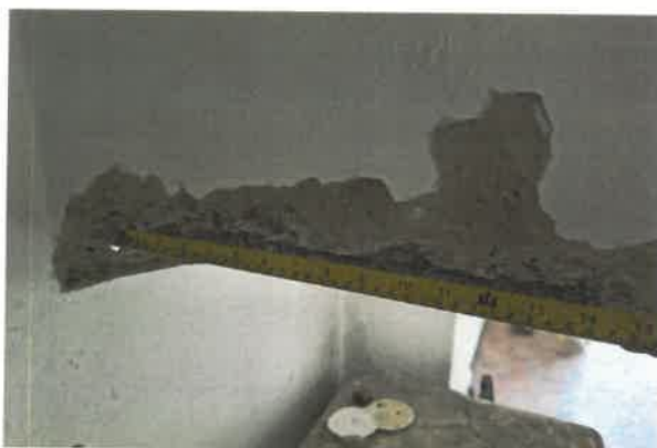
Sondaj GR01 grinda beton armat monolit ax C,3-4, parter: secțiune transversală 30x60cm, armare longitudinală 4Ø16 PC52, armare transversală Ø6 OB37/35cm
