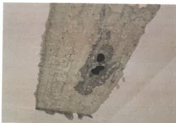
Sondaj PL01 placa beton armat prefabricat ax C-D,3-4, peste etaj 2: latime fasie=120cm , grosime fasie=12cm ,
