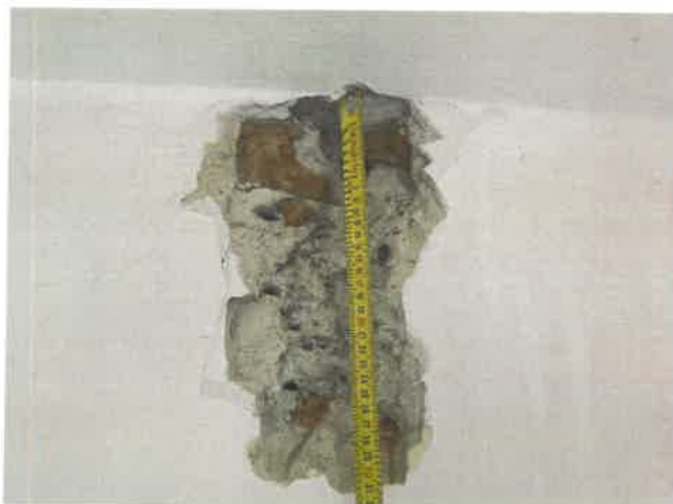
Sondaj CZ01 centura beton armat ax 2, D-E, etaj 2: secțiune transversală 30x25cm
