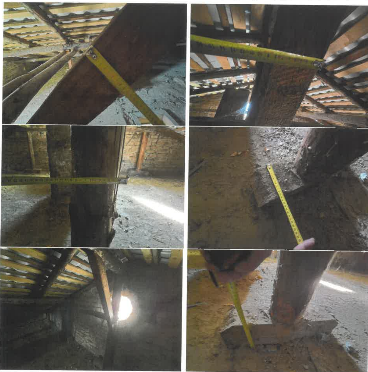
Masuratori sarpanta: capriori 8cm, pane \varnothing 10 cm, popi \varnothing 12 cm, talpi 12x12cm, elementele nu sunt ancorate de structura de rezistenta;
