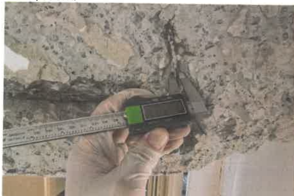
Sondaj GR01 grinda beton armat monolit ax 3,C-D, etaj 2: secțiune transversală 30x60cm, armare longitudinală 4Ø16 PC52, armare transversală Ø6 OB37/35cm;
