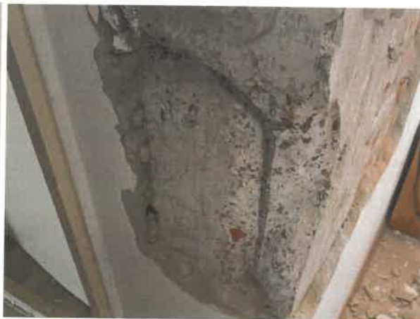
Sondaj SZ01 sambure beton armat monolit ax 3-C, etaj 2: secțiune transversală 30x30cm, armare longitudinală 4Ø14 PC52, armare transversală Ø6 OB37/30cm.
